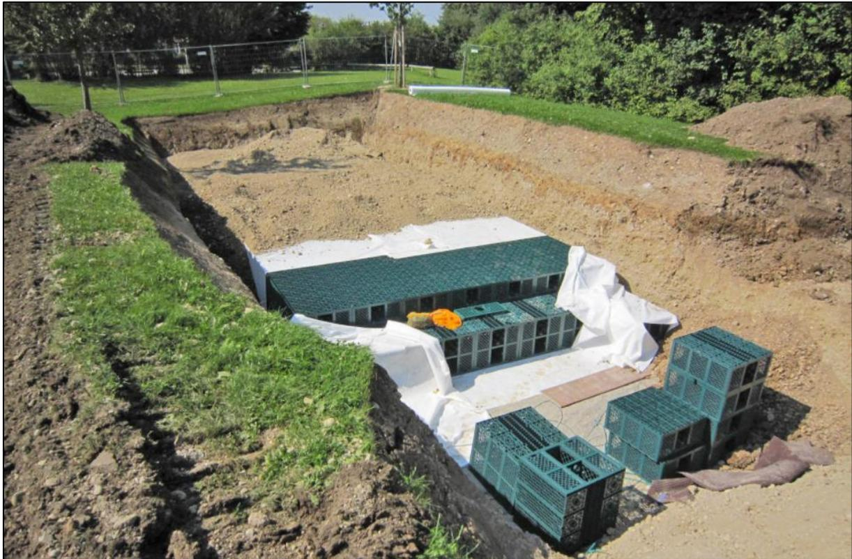
Abbildung 10: Ausführungsmöglichkeit einer Füllkörperrigole [Quelle: <https://www.energiesystemtechnik.de/images/referenzen/aying-gs/aying-gs02.jpg/>, 22.01.2021]
