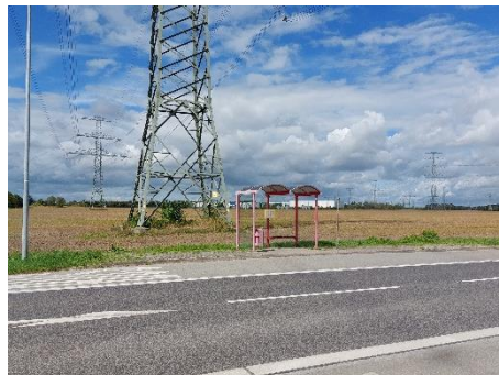
Abbildung 7: Bushaltestelle Umspannwerk, Richtung S Hoppegarten
