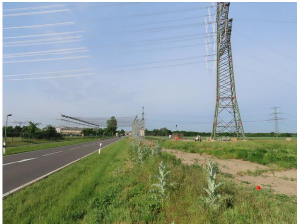
Abb. 2: Blick entlang Altlandsberger Straße im Südosten
