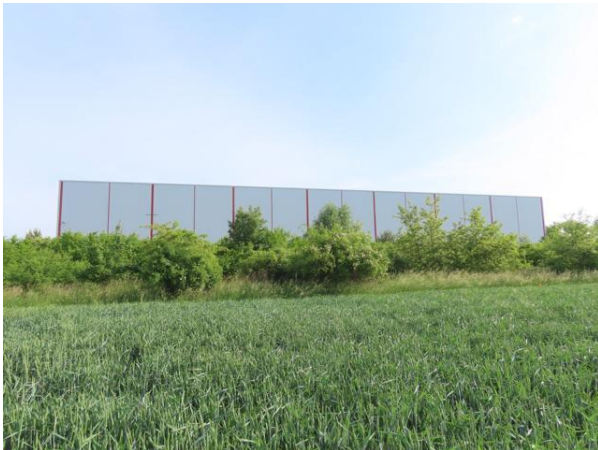
Abb. 8: Gehölzbestand vor dem Logistikzentrum im Nordwesten
