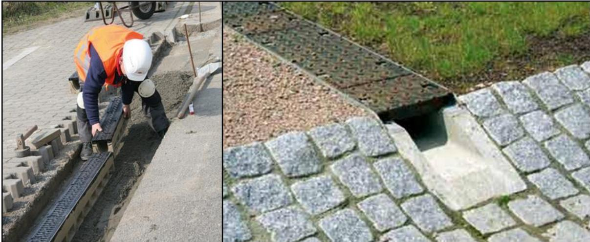
Abbildung 11: Beispiel Rinnenverlegung- und Zuleitung in Versickerungsbereichen [Quelle: links <https://www.aco-tiefbau.de/>, Zugriff: 10.08.2018 und rechts <https://www.birco.de/>, Zugriff: 10.08.2018]
