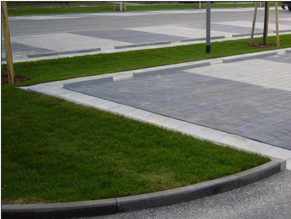
Abbildung 10: Beispiel: Muldenversickerung für Parkplätze [Quelle: <http://www.engelmann-im-netz.de/index.php?id=174>, Zugriff: 16.04.2018]
