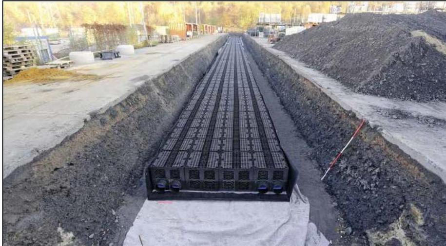
Abbildung 4: Ausführung einer Rigole mit Kunststofffüllkörper der Fa. Rehau [Quelle: Fa. Rehau, 2016]
