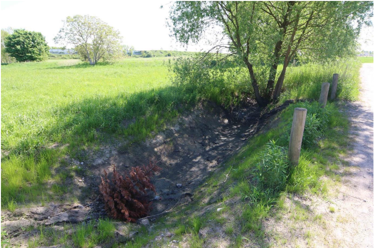
Abb. 8: Versickerungssenke des Entwässerungsgrabens am Gruscheweg
