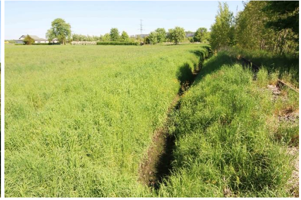
Abb. 7: Entwässerungsgraben entlang des Bahndamms
