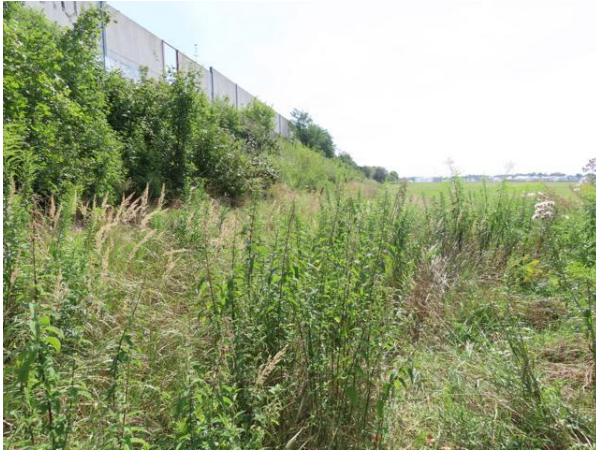
Abb. 2: Damm entlang der A 10
