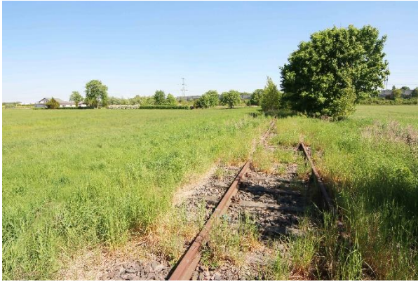
Abb. 6: Blick entlang des Bahndamms
